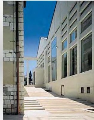
Schalungsglatter weißer Ortbeton
