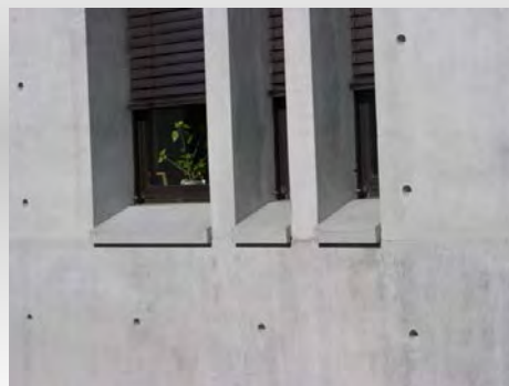
Fensterbänke aus Fertigteilen
