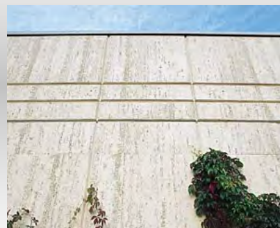
Großformatige Betonfertigteile mit Travertinstruktur
