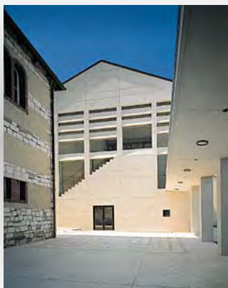
Weißbeton mit abgedichteten Schalungsstößen
